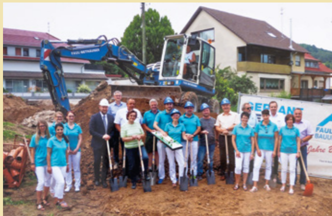
Beim neuen Praxisgebäude packt jeder mit an
