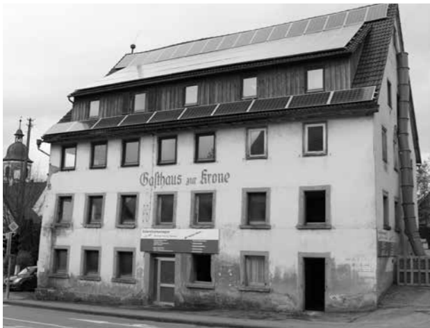
Das Gasthaus Krone in Jagstheim vor der Sanierung
