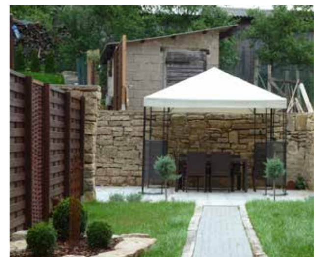
Bei der Gestaltung des Gartens wurden alte, für die Region typische Muschelkalk-Bruchsteine des Gewölbekellers wiederverwendet.
