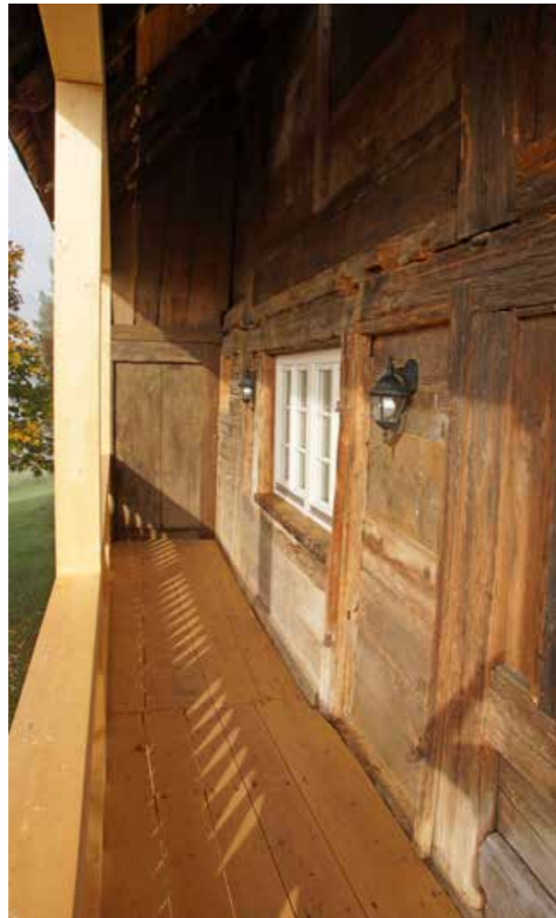
Modernisierung eines Schwarzwaldhofes in Bernau: Die Fassade lässt Alter und Geschichte des Hofes spüren. Sie wurde größtenteils in ihrem Zustand belassen und nur an einigen Stellen sorgfältig repariert. Der alte Laubengang wurde durch einen neuen Balkon ersetzt. So konnten die Kosten für die Sanierung der Fassade im Rahmen gehalten werden. Projekt Kramkowski, S. 76-77
