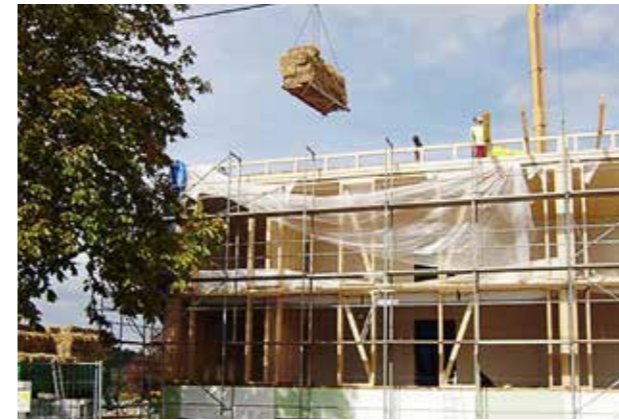
Neubau in Kreenheinstetten: Das neue Gebäude wird als Strohballen-Lehmhaus errichtet. Alle verwendeten Baumaterialien sind biologisch und wiederverwendbar. Das in die Holzständerkonstruktion eingebaute Stroh dämmt sehr gut und schafft in Verbindung mit dem verwendeten Lehmputz ein gutes Raumklima. Die Bauweise ist sehr ressourcenschonend. Projekt Schad, S. 91.
