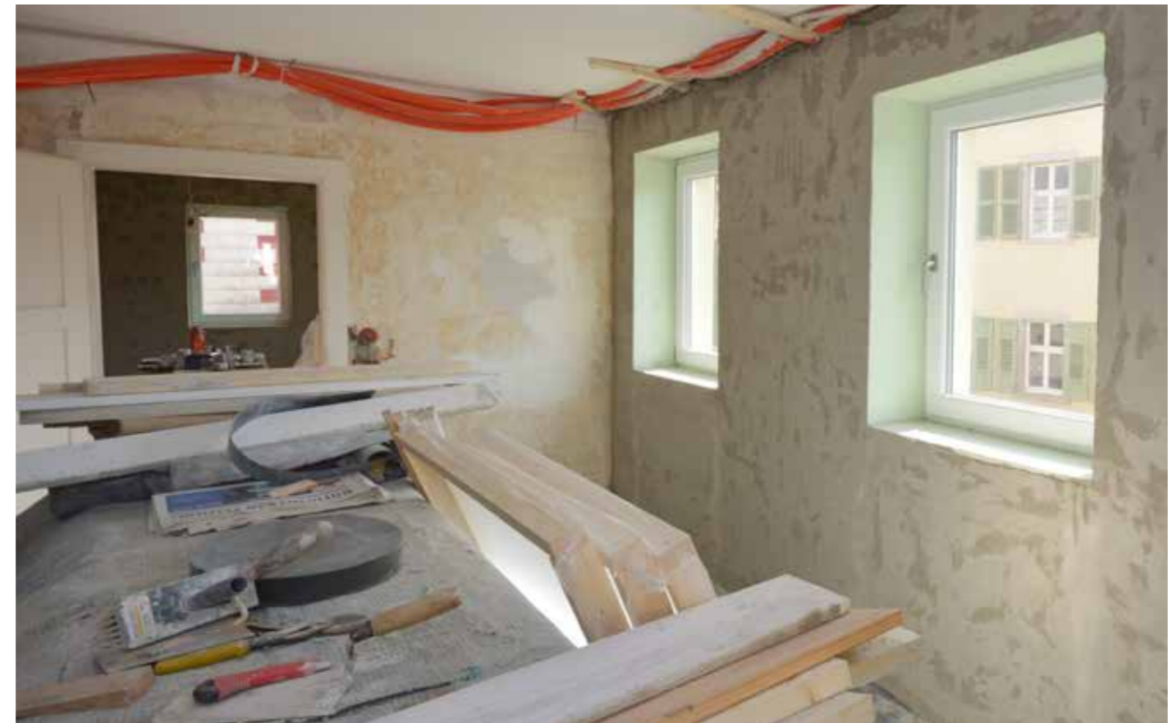
Wandaufbau: Holzweichfaserplatte, Kalkputzhaftgrund, Heizschlaufen, mehrfach Kalk-Grundputz, Naturkalk-Edelputz
