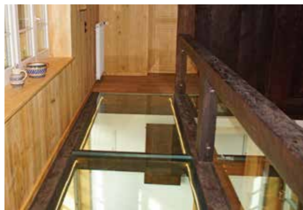
Modernisierung und Umnutzung eines Schwarzwaldhofes in Bernau: Die in den 1970er Jahren eingezogene Decke in der alten Rauchküche wird wieder geöffnet (Foto s. S. 77). Die Räume im Obergeschoss werden über eine Galerie aus Glas verbunden. Damit wird der Eindruck einer durchgehenden Zweigeschossigkeit hergestellt. Projekt Kramkowski , S. 76-77
