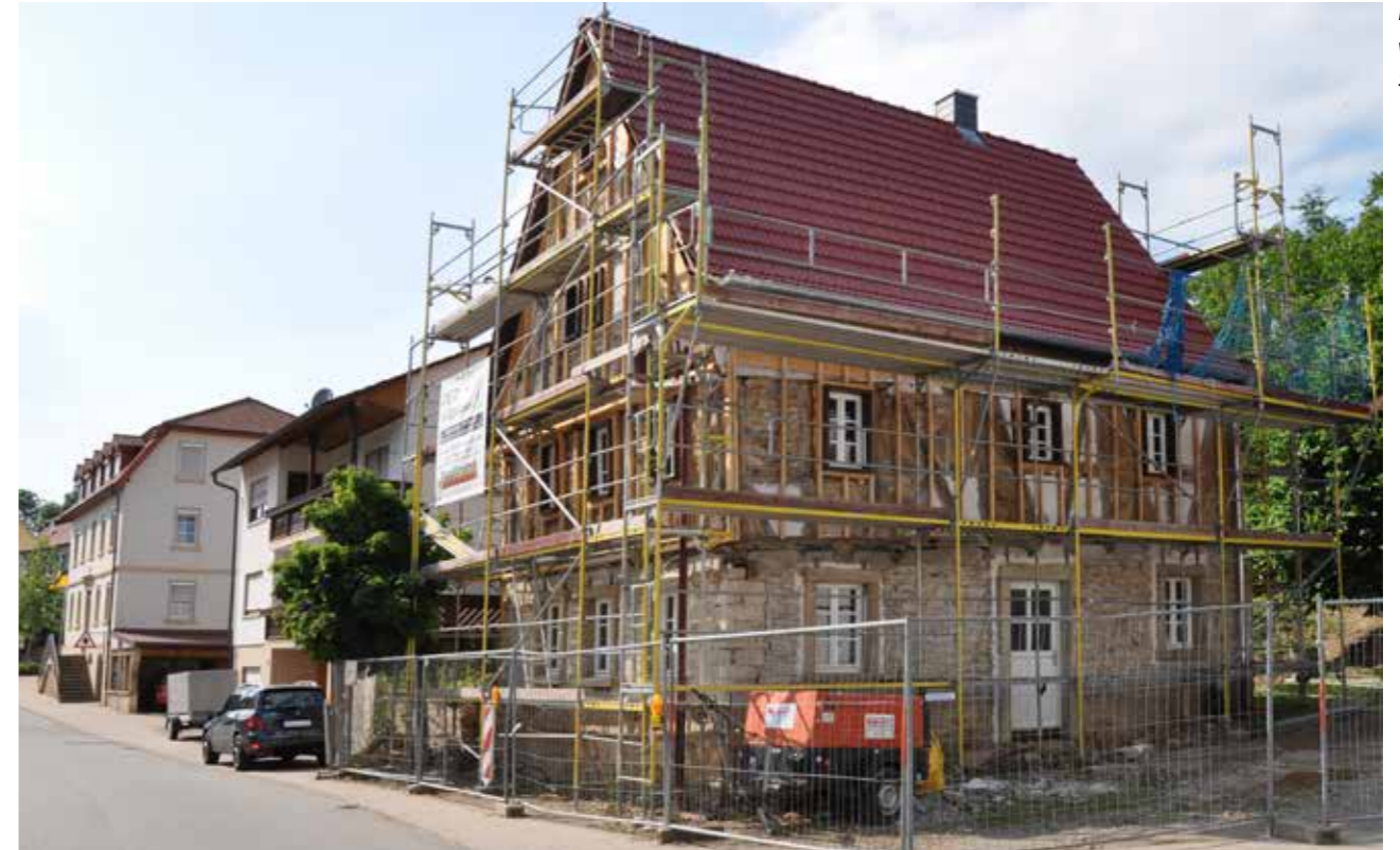
Das Wohnhaus während der Sanierung
