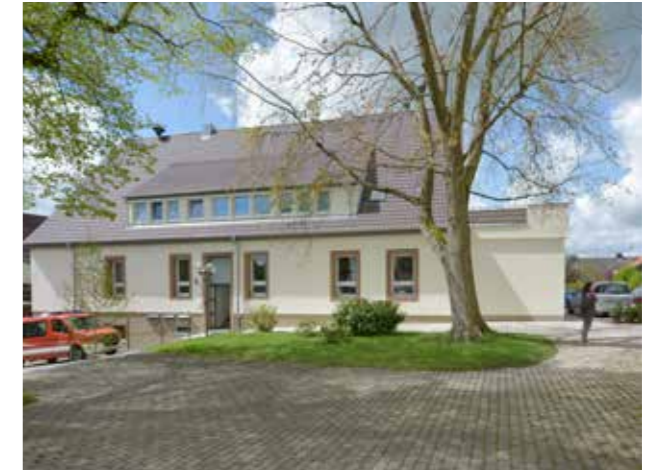
In der ehemaligen Schule in Jagstheim wird jetzt gewohnt und gearbeitet.
