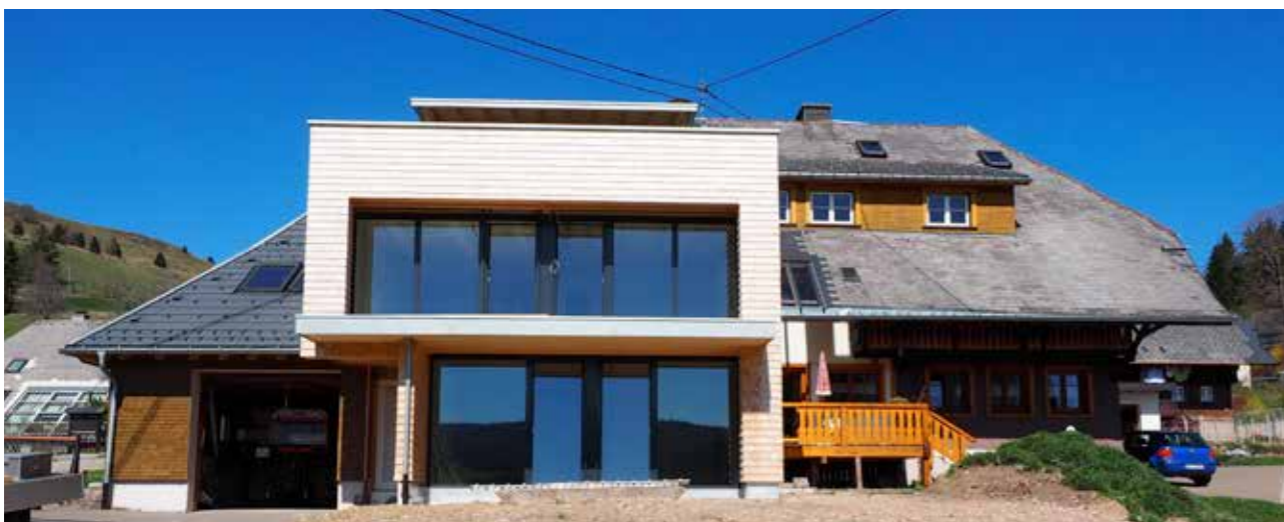
Der Wohnteil des Schwarzwaldhofs wird durch den Umbau erweitert.
