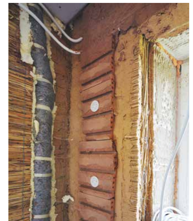
Modernisierung des Schlosses in Michelbach: Die alten Wände werden neu aufgebaut und gedämmt. Neuer Wandaufbau: altes Mauerwerk/Fachwerk, Grundlehmputz, Schilfmatten, Wandheizung, Auflehmputz, Kalkputz. Projekt Schloss Michelbach, S. 82-83
