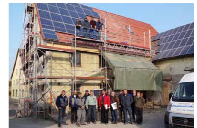
In Jagstheim werden in einem ehemaligen Gasthaus Mietwohnungen eingebaut.
